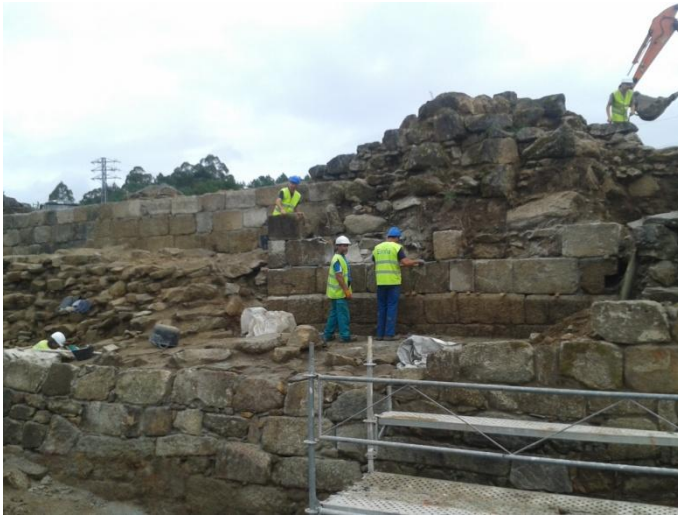
Tarefas de restauración e consolidación (Concello de Santiago de Compostela)
